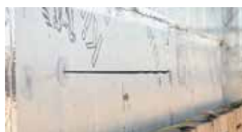
Dualfix inox aisi 304 spouwanker positioneren
