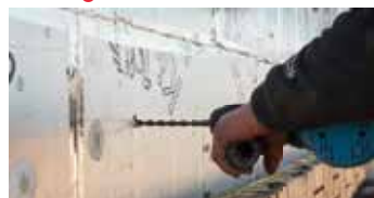
boren 9mm: holle materialen boren 9.5mm: volle materialen
