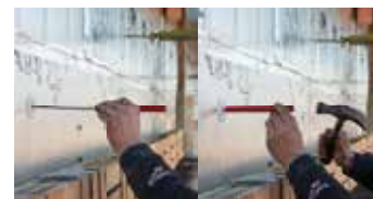
Spouwanker monteren m.b.v. aangepast inslagpijpje (L anker - L plug+10mm)
