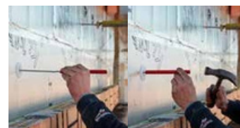
Spouwanker monteren m.b.v aangepast inslagpijpje (L anker - L plug + 10 mm)
