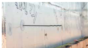
Dualfix inox aisi 304 spouwanker positioneren
