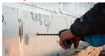
boren 9mm: holle materialen boren 9.5mm: volle materialen
