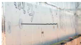
Dualfix inox aisi 304 spouwanker positioneren
